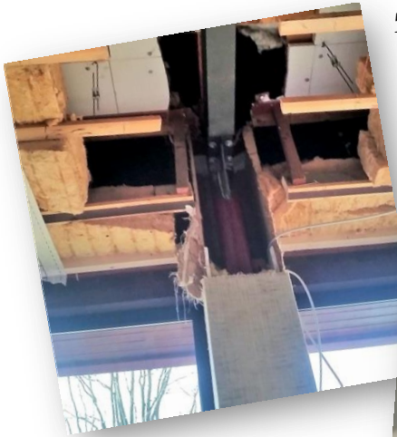
Im Gemeindehaus während der Bauarbeiten
